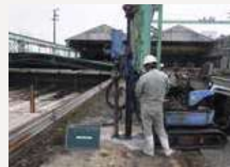
図⑤ 土壤調査(採取状況)
